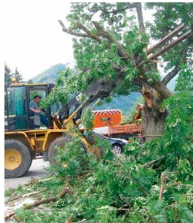
ten nicht zu stoppender Pilzbefall aufgrund eines bereits einige Jahre zurückliegenden Blitzeinschlages führte zu einem desolaten Zustand der Esche.
